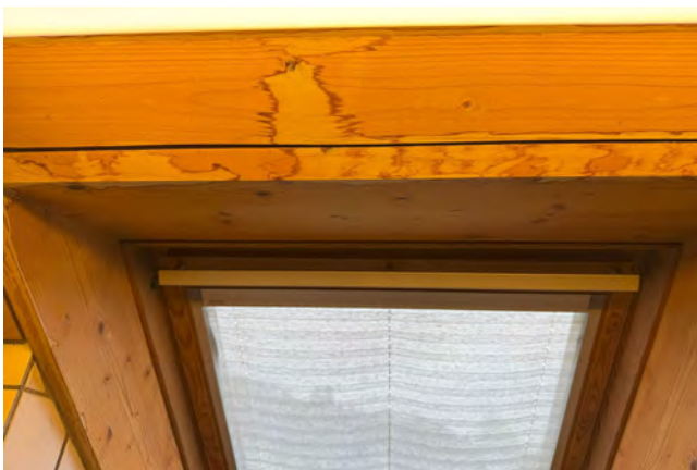
Dachfenster Wasserflecken
